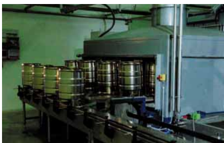
Bild 5: Teilansicht des Regenerationsofens während des Betriebs
